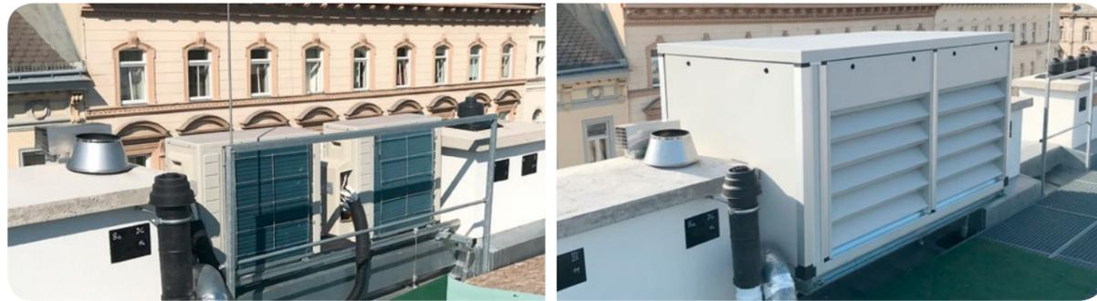
Montage ultérieur avec boîtier type KVT220N (sans fond) sans interruption du fonctionnement de refroidisseur en continu.
